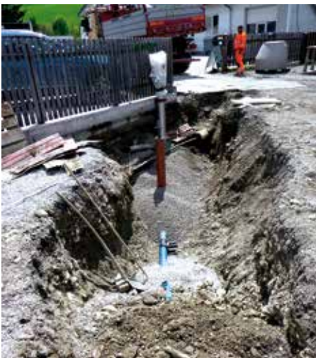
Arbeiten in der Hans-Wödl-Gasse .
