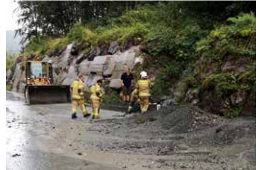
Am 14. August kam es nach heftigen Regenfällen zu einer Vermurung der Straße in die Forstau .
