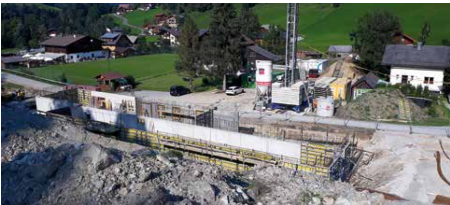
Im Untertal wurde mit dem Bau des Rüsthauses und Vereinsgebäudes begonnen.
