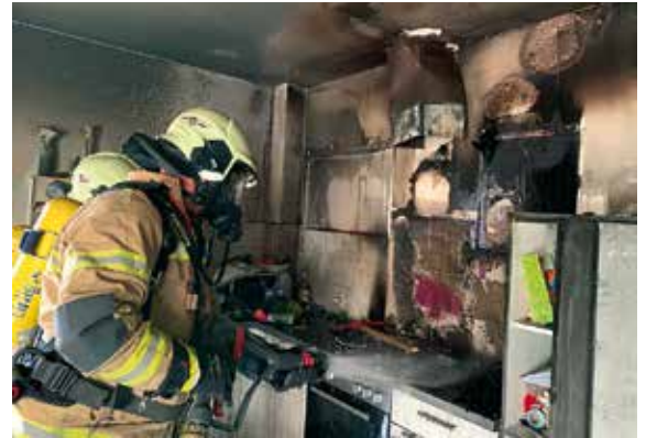
In einem Mehrparteienhaus in der Coburgstraße kam es am 1. März zu einem Küchenbrand . Mittels schwerem Atemschutz konnten wir den Brand rasch löschen.
