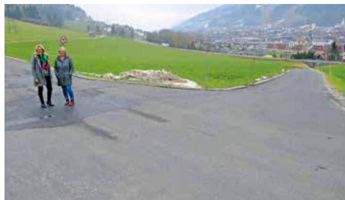
Nachdem die Vorberg- und Preuneggstraße saniert waren, standen u.a. Straßenzüge im Stadtgebiet an (im Bild: die Kreuzung beim Holdhof). Die Liste an Straßensanierungen für 2020 ist auch schon wieder sehr lang.
