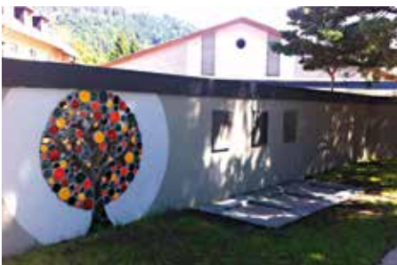
Aufgrund der steigenden Nachfrage wurde am Kommunalfriedhof, an der Nordseite der bestehenden Friedhofsmauer, die Möglichkeit für Urnenbeisetzungen geschaffen.
