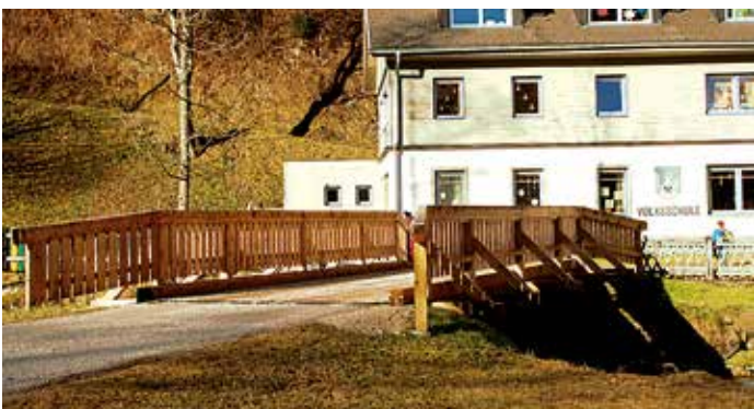
Alle 84 Brücken im Gemeindegebiet wurden einer statischen Überprüfung unterzogen. Im Zuge dessen wurde z.B. die Brücke zur Volksschule im Untertal erneuert.
