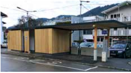
Die neue öffentliche, barrierefreie WC-Anlage im Bereich des Apothekenparkplatzes, mit einem überdachten Wartebereich für die Bushaltestelle, wurde fertiggestellt.
