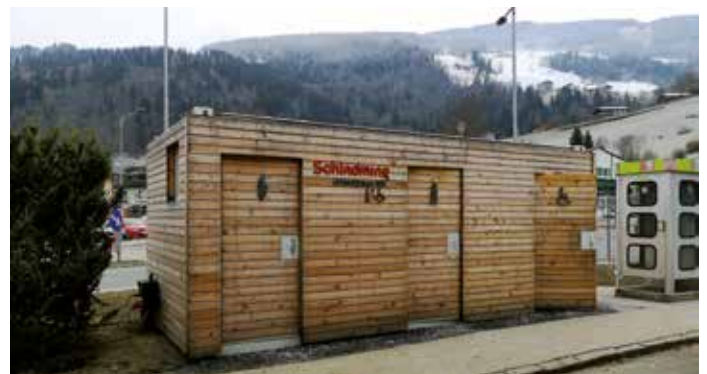
Neue barrierefreie WC-Anlage am Lendplatz.
