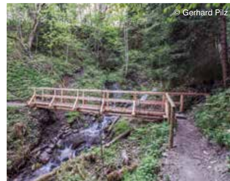
Die neue Brücke am Oberen Talbachweg.
