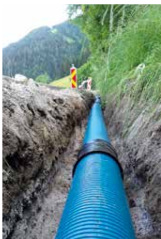
Sanierung der Oberflächen- und Straßenentwässerung auf der Preuneggstraße.
