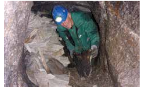
Bild oben: Im Zuge der Sicherungsarbeiten 2017, die zusammen mit der Montanbehörde Süd und DI Sepp Karrer durchgeführt wurden, konnte ein loser Deckenstein vom Lüftungsschacht geborgen werden.
