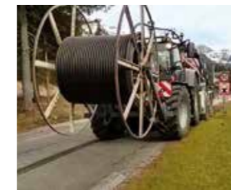
Verlegung der Leerverrohrung in der Vorbergstraße.
