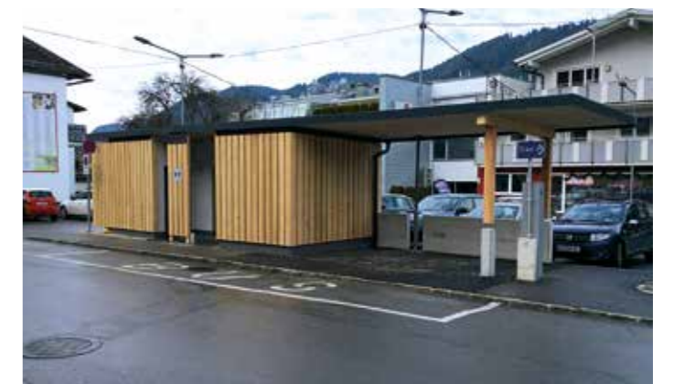
Die neue öffentliche, barrierefreie WC-Anlage im Bereich des Apotheken- parkplatzes mit einem überdachten Wartebereich für die Bushaltestelle.
