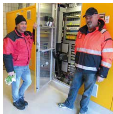
Hans Hofer und Otmar Kleer vor einem der zahlreichen Steuerungskästen.
