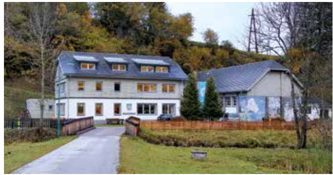
Der Zaun der Volksschule Untertal wurde erneuert.
