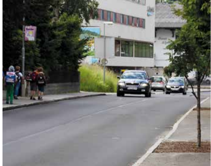
Die Erzherzog-Johann-Straße nach der Sanierung im Mai 2014
