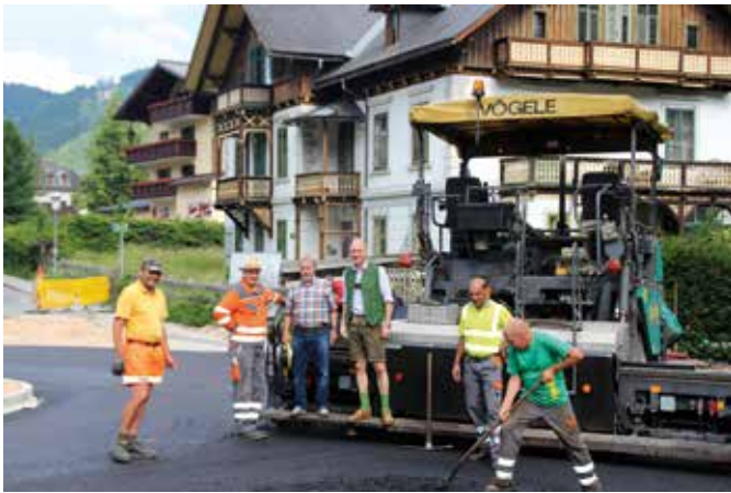
Auch 2014 sind einige Straßenerneuerungen durchzuführen, wie an der Erzehrzog-Johann-Straße oder am neuen Kreisverkehr „Polizei“, dessen Fertigstellung für Anfang Juli vorgesehen ist.
