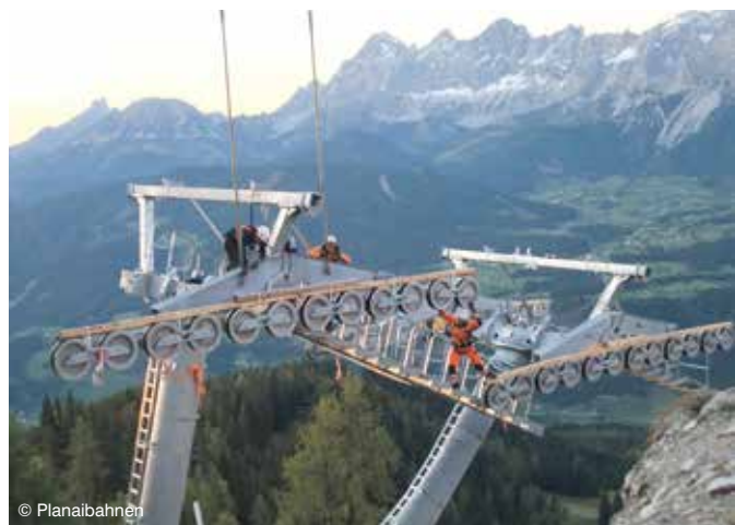
Eine Aufnahme von der Stützen-Montage lässt die Dimension der neuen Hochwurzen-Gipfelbahn erahnen.
