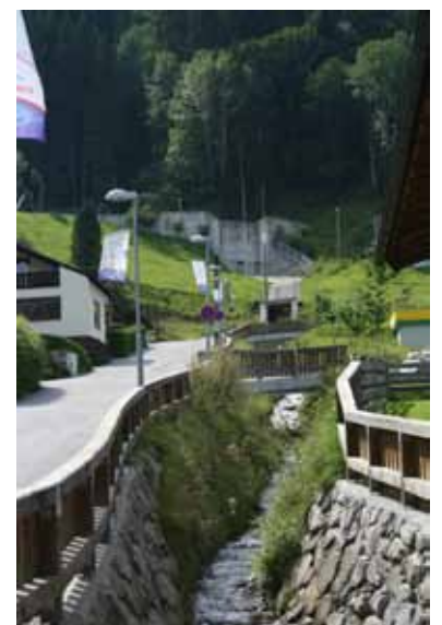
Die Verbauung am Trenkenbach war eine Grundvoraussetzung für die erfolgreiche Bewerbung zur Alpinen Ski WM 2013.
