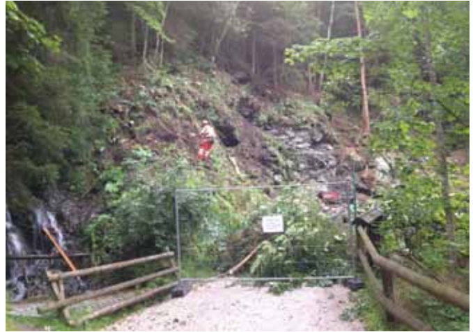
Sicherheitsarbeiten auch am Talbach-Eingang.
