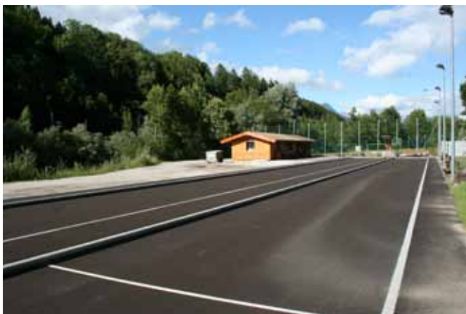
Auch an die Vereine wurde gedacht. Durch den Abriss der Dachstein-Tauern-Halle verloren die Eisschützen ihre Anlage. Jetzt gibt es wieder optimale Trainings- und Sportmöglichkeiten.
