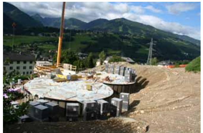
Der Hochbehälter I am Sonnenhang, hinter dem Hotel Tauernblick, wird auf 1000 m 3 Fassungsvermögen ausgebaut.
