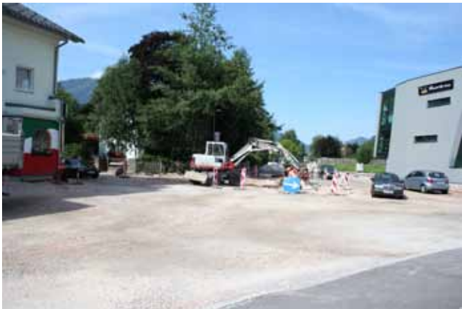
Wir wissen aus Erfahrung, welche verkehrstechnische Erleichterung ein Kreisverkehr bedeutet. Im Bereich Erzherzog-Johann-Straße/Lange Gasse entsteht soeben ein neuer.
