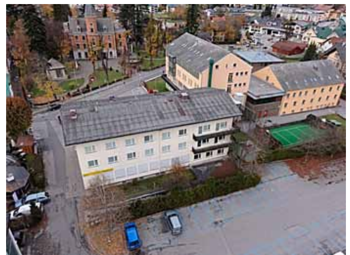
Anhand dieser Aufnahme von oben lässt sich erahnen, welche Ausmaße der Medal Plaza erreicht, wenn das Postgebäude weggommt.
