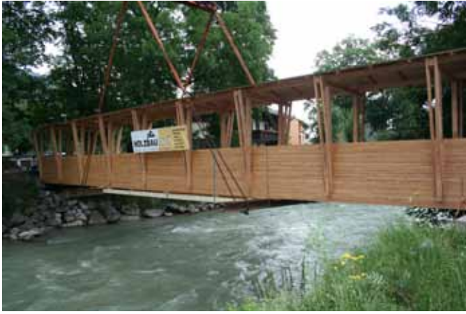
Der Fußweg vom Bahnhof zur Planai führt unter anderem über den DKH-Steg, der erneuert werden musste.
