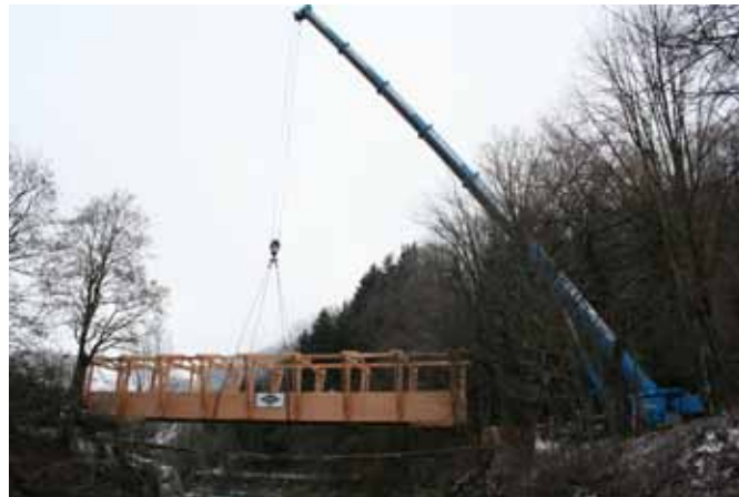
Der Gollobsteg musste erneuert werden. Zur WM wird er Besuchern den Weg zur Planai verkürzen.
