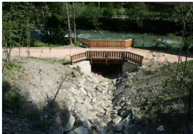
Ein Teil der Starchlbach-Verbauung, am Zufluss zur Enns.
