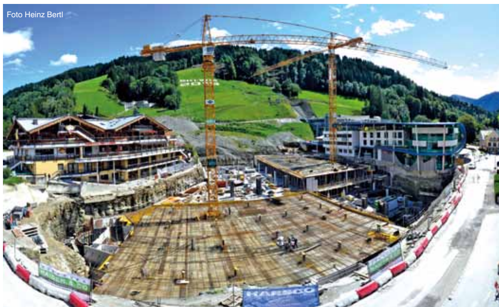
Der neue „WM-Park Planai“ wird zu Europas modernster Tiefgarage.
