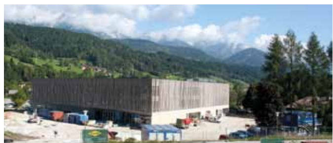
Das Mediencenter Anfang Oktober 2011, kurz vor der Fertigstellung.
