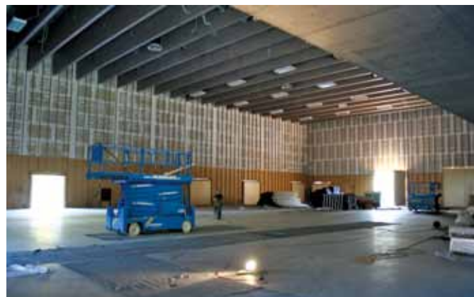
Alleine die Einrichtung des Mediencenters, zurzeit noch in Bau, schlägt für die Gemeinde mit 810.000,- Euro zu Buche.
