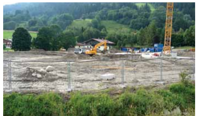
4. August 2010: Baubeginn des Mediocenters
