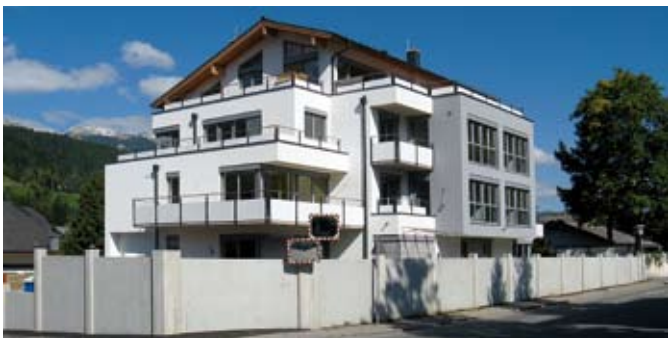
Wohn- und Bürohaus in der Erzherzog-Johann-Straße
