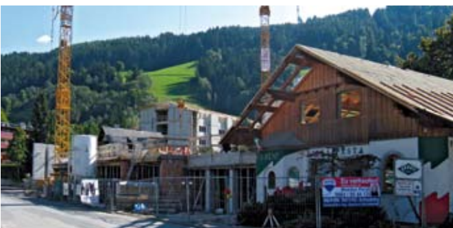
Bau von 15 neuen Wohnungen in der Erzherzog-Johann-Straße (Hako)
