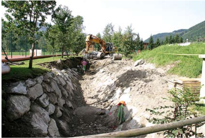
Wildbachverbauung am Trenkenbach (Bild oben und unten)
