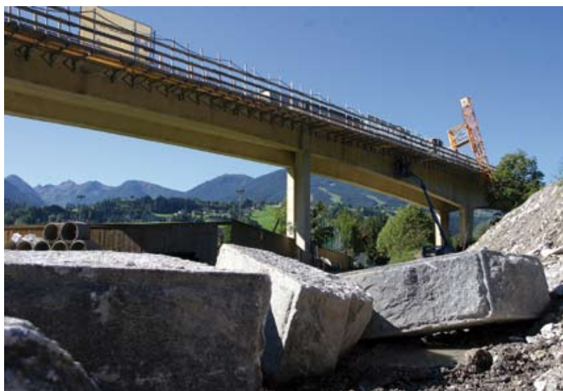
Sanierung der B 320
