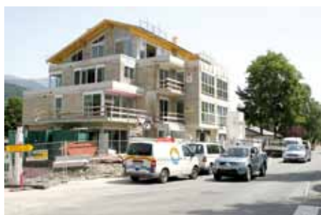
Wohn- und Bürohaus in der Erzherzog-Johann-Straße
