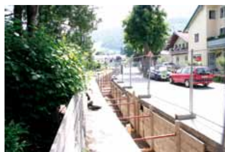
Erweiterung des Fernwärmenetzes
