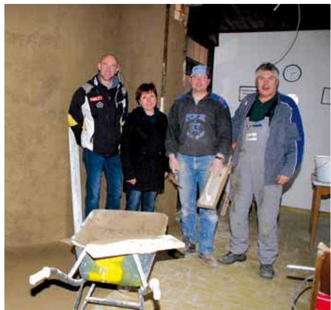
Bürgermeister Jürgen Winter und Gemeinderätin Astrid Wanke überzeugen sich vom Baufortschritt in der Aufbahrungshalle
