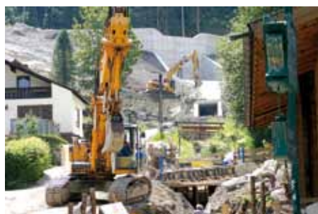
Wildbachverbauung am Trenkenbach
