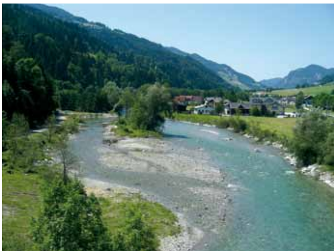
Ein Blick auf die eröffnete Hochwasserschutzmaßnahme in der Salzburger Siedlung
