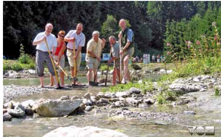
V.l.n.r.: LR Hans Seitinger, Hildegard Eitzinger, DI Rudolf Hornich, OBR Manfred Marko, Vzbgm. Ing. Toni Streicher und Bgm. Jürgen Winter beim symbolischen Spatenstich.
