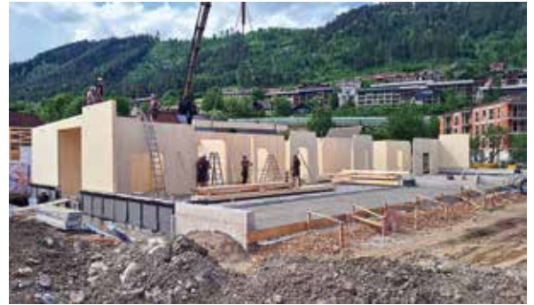
Bild rechts: Beginn Montage- arbeiten Holzbau (Dienstag, 30.5.2023)
