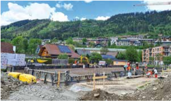
Bild links: Betonieren Bodenplatte (Montag, 22.5.2023)
