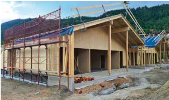
Bild links: Dach dicht (Freitag, 2.6.2023)
