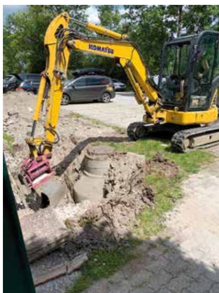
Die langersehnten Kanal-Grabungsarbeiten haben begonnen.
