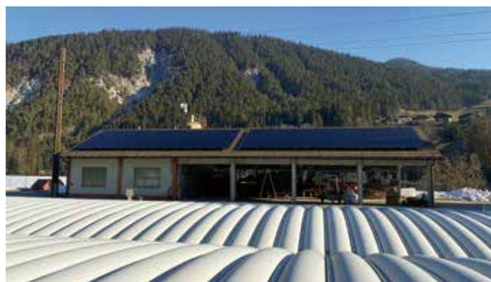
Presshaus mit PV-Anlage.
