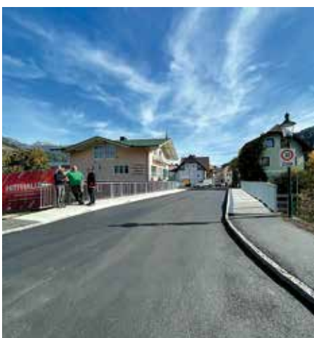
Die Talbachbrücke nach der Sanierung.
