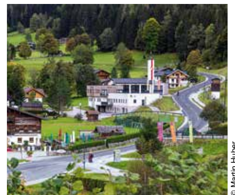
Die sanierte Untertalstraße.
