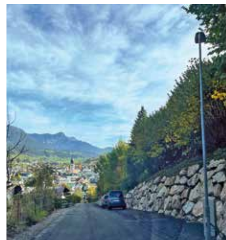
... und nach Sanierung.
